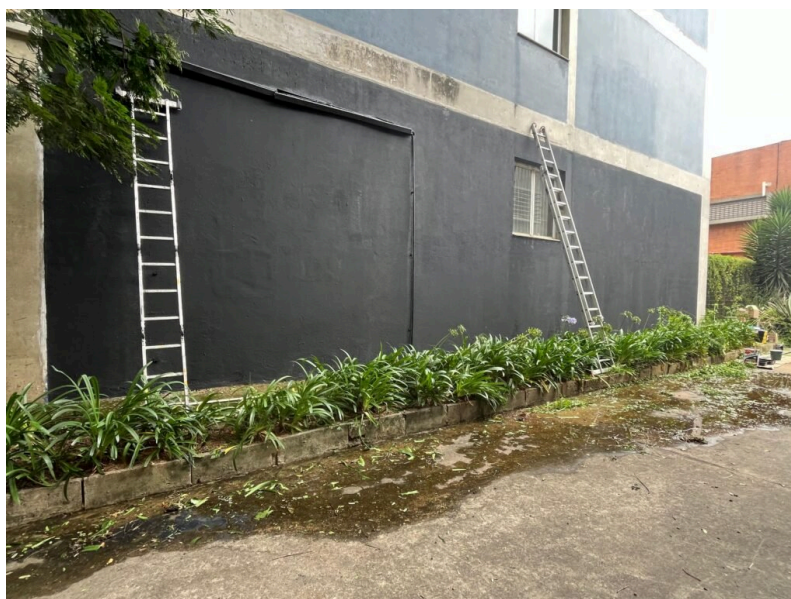
Parede na Cidade Universitária antes da Intervenção
